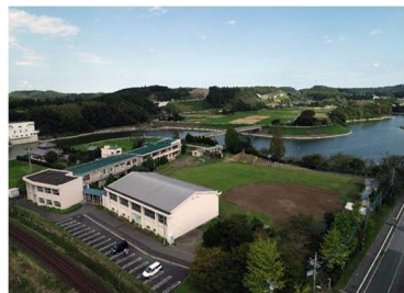
改修前の旧高滝小学校
