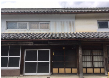
改修対象施設
