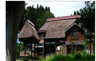
再生古民家「平左衛門」
