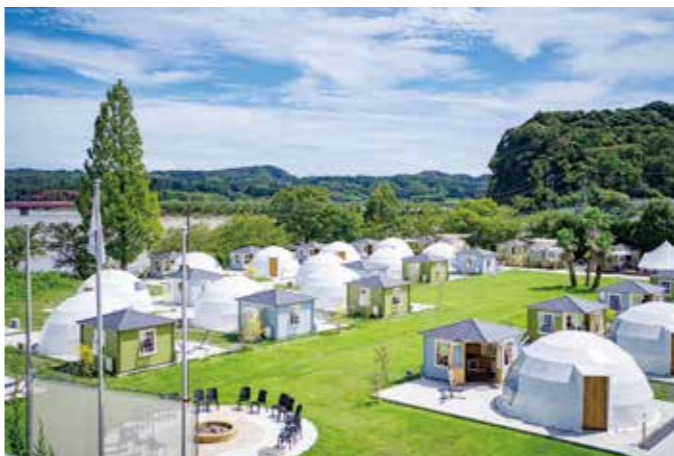
完成後のグランピング施設
