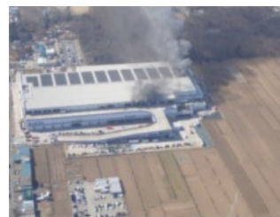
【平成29年2月埼玉県三芳町で発生した大規模物流倉庫火災】
