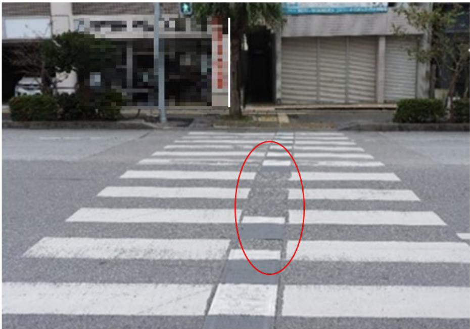
事例⑧-4 場所：市道 那覇市（泉崎2丁目 重点整備地区）
