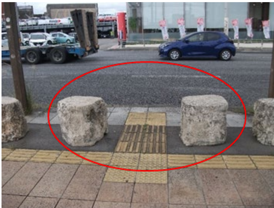
事例④-3 場所：国道329号 沖縄市（農民研修センター前バス停） 誘導用ブロックに障害物が近接
