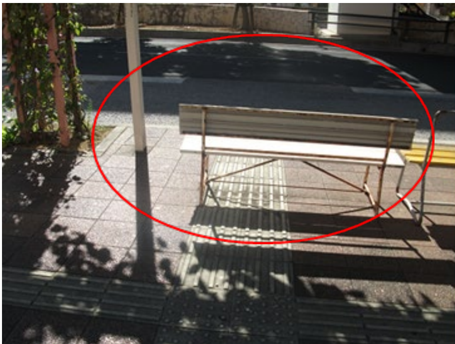
事例④-5 場所：県道82号 那覇市（儀保駅前バス停） 誘導用ブロックに障害物が置かれている
