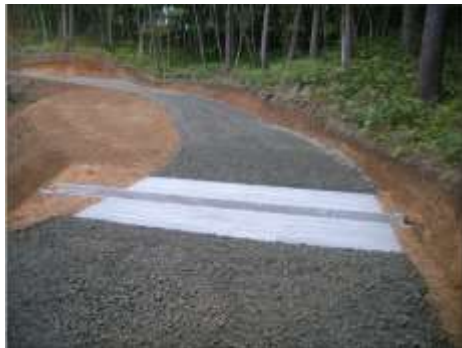
林道（林業専用道）開設
