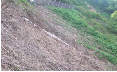
【着手前】落石防護柵
