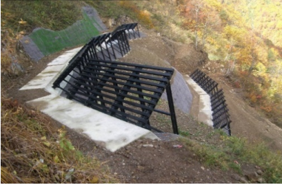
【H25完成】落石防護柵
