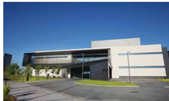
令和2年に運用を開始した高砂熱学イノベーションセンター。
