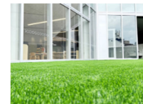
(園庭の整備、改修)
