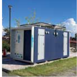
太陽光発電で運転、浄化処理可能な自己完結型トイレを東部交通公園に設置。
