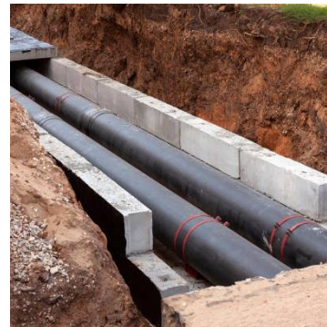
管路 約60万km
