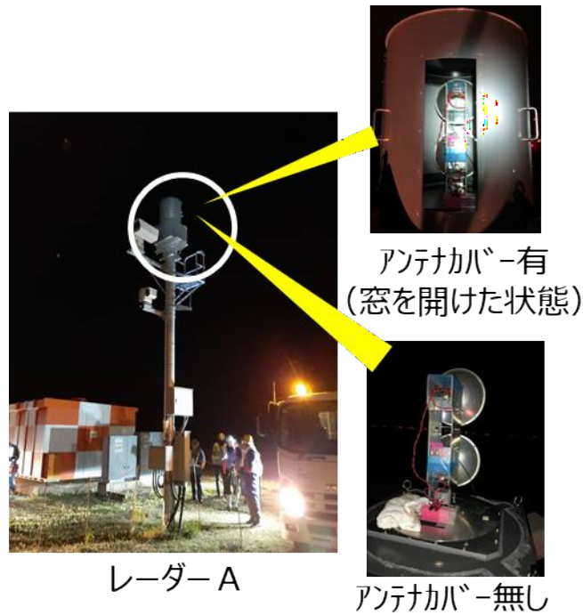
図 7 レーダー設置状況と測定条件
