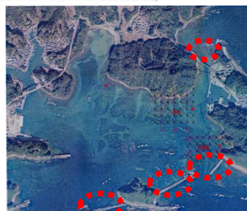
防波堤整備箇所(赤点線部分)
