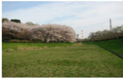
野川第一調節池
