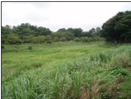
野川第一調節池 (東側)
