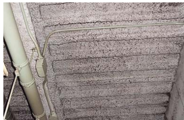
吹付けロックウール
