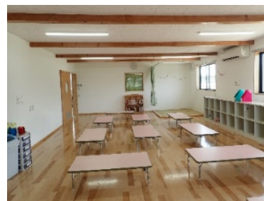
＜公共施設の内装木質化＞
