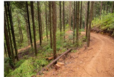
＜作業道整備後の様子＞
