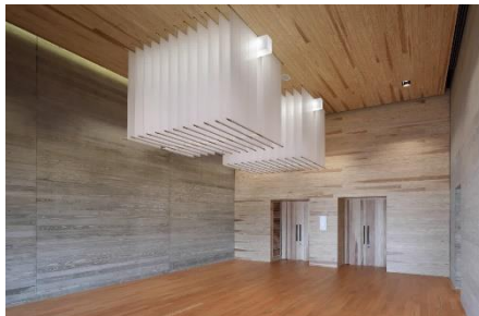
【西播磨産材を活用した内装木質化】
