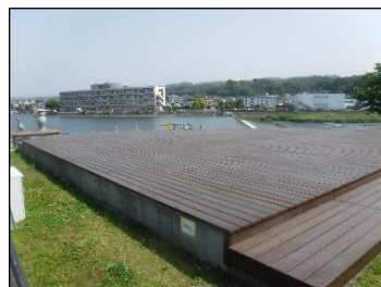
（事業2：三隈川公園ウッドデッキ）
