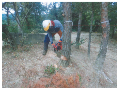
（枯死した松の伐倒作業）
