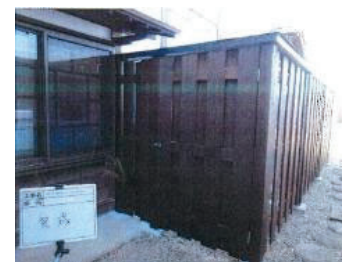
（花久の里外構工事）
