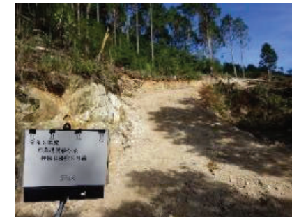
（森林作業道補修支援） 作業完了後
