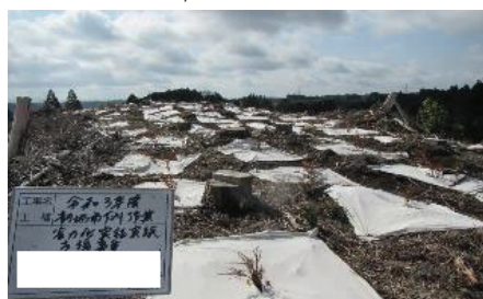
(防草シート設置状況)
