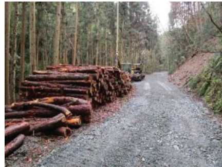
（林道補修後の状況）
