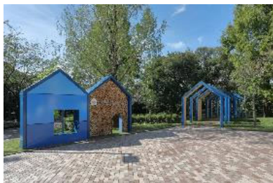
（完成写真：メインゲート）
