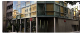
▲センターの設置（林業会館）
