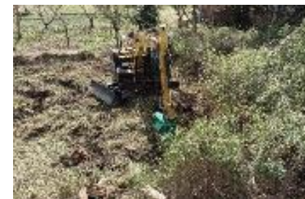
〈機械による地拵作業〉
